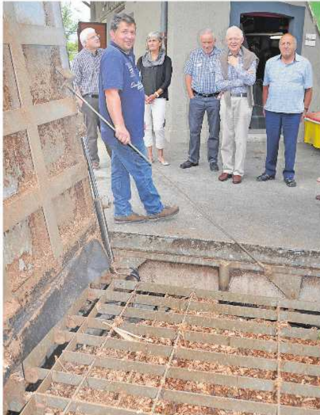
Der Bunker fasst 150 Kubikmeter Holzschnittzel. Wird Buchen- und Eichenholz geliefert, so wiegt der Kipper 38 Tonnen.
